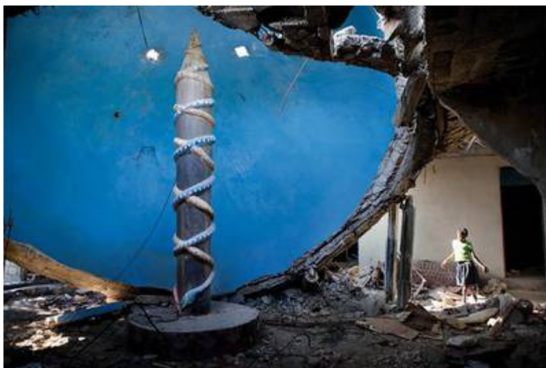
Die einsturzgefährdete Kuppel des ehemaligen Kulturzentrums kann nur mit großen Baumaschinen abgeräumt werden (Foto: Jonas)
