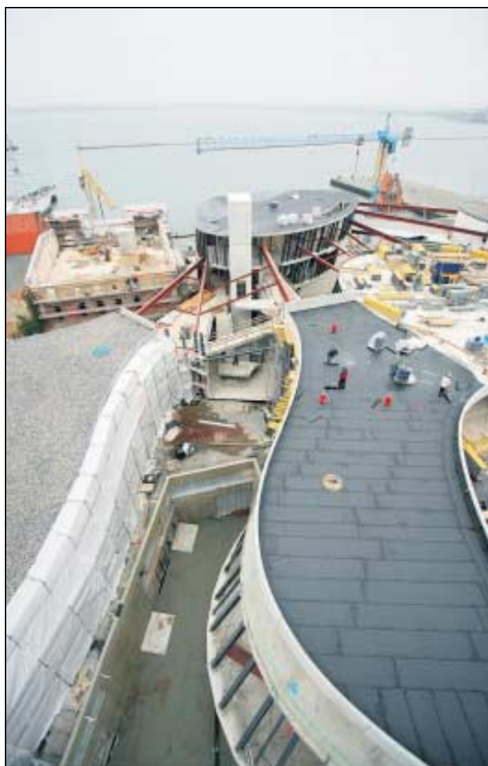
Blick auf die Ozeaneum-Baustelle.
